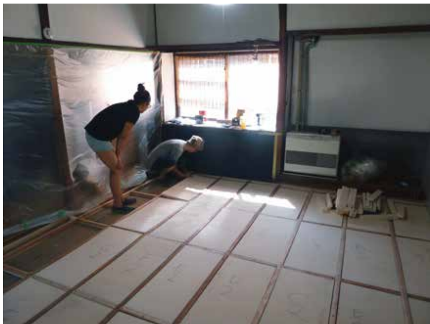
事務所となる部屋の畳を床に張り替える作業
