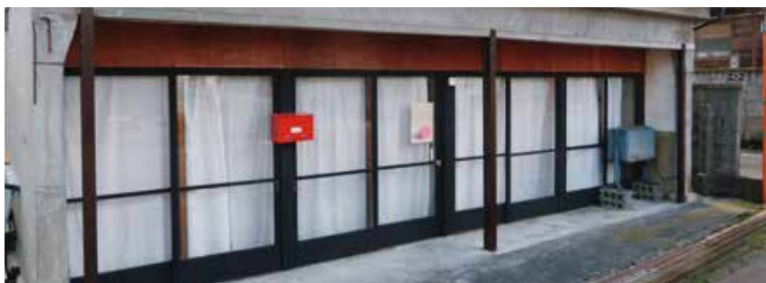
剥がれ落ちていた入り口上部の板を張り替えました
