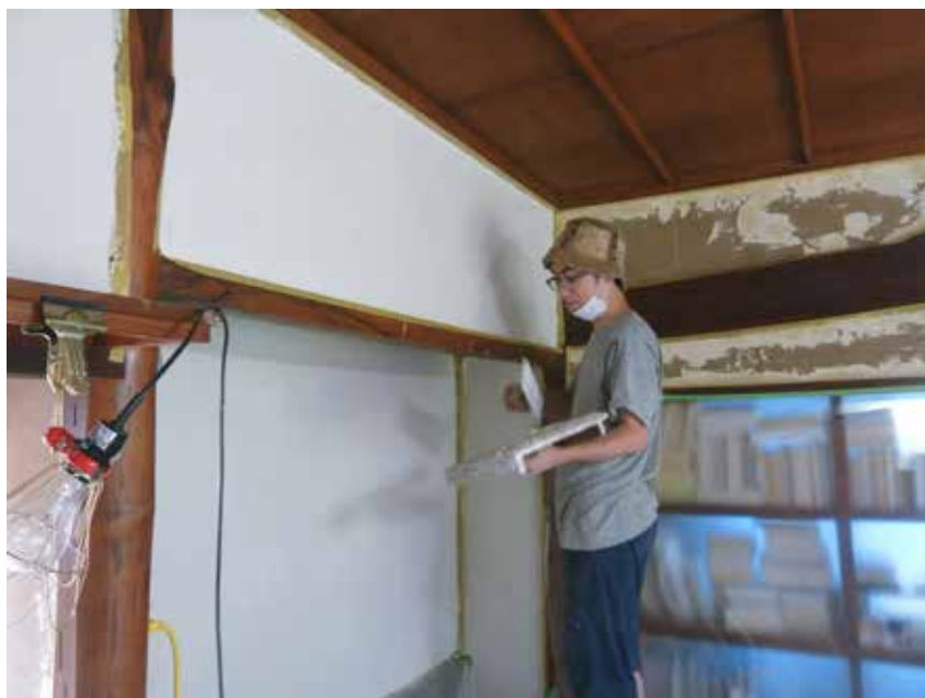
樋口さんの手ほどきを受けながら漆喰を塗装
